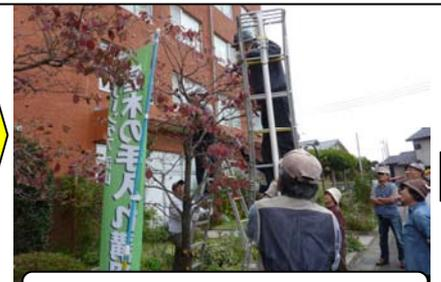
左右の柱に元節止めと末節止めを交互に止めます、節の位置を間違えないように寸法を確かめ胴縁の作成中です。
